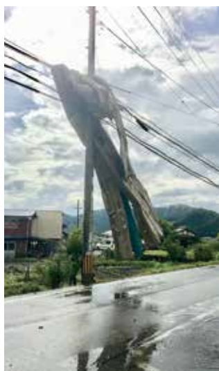
▲米原市で発生した竜巻被害
